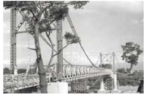
昭和31年 鉄製吊橋
