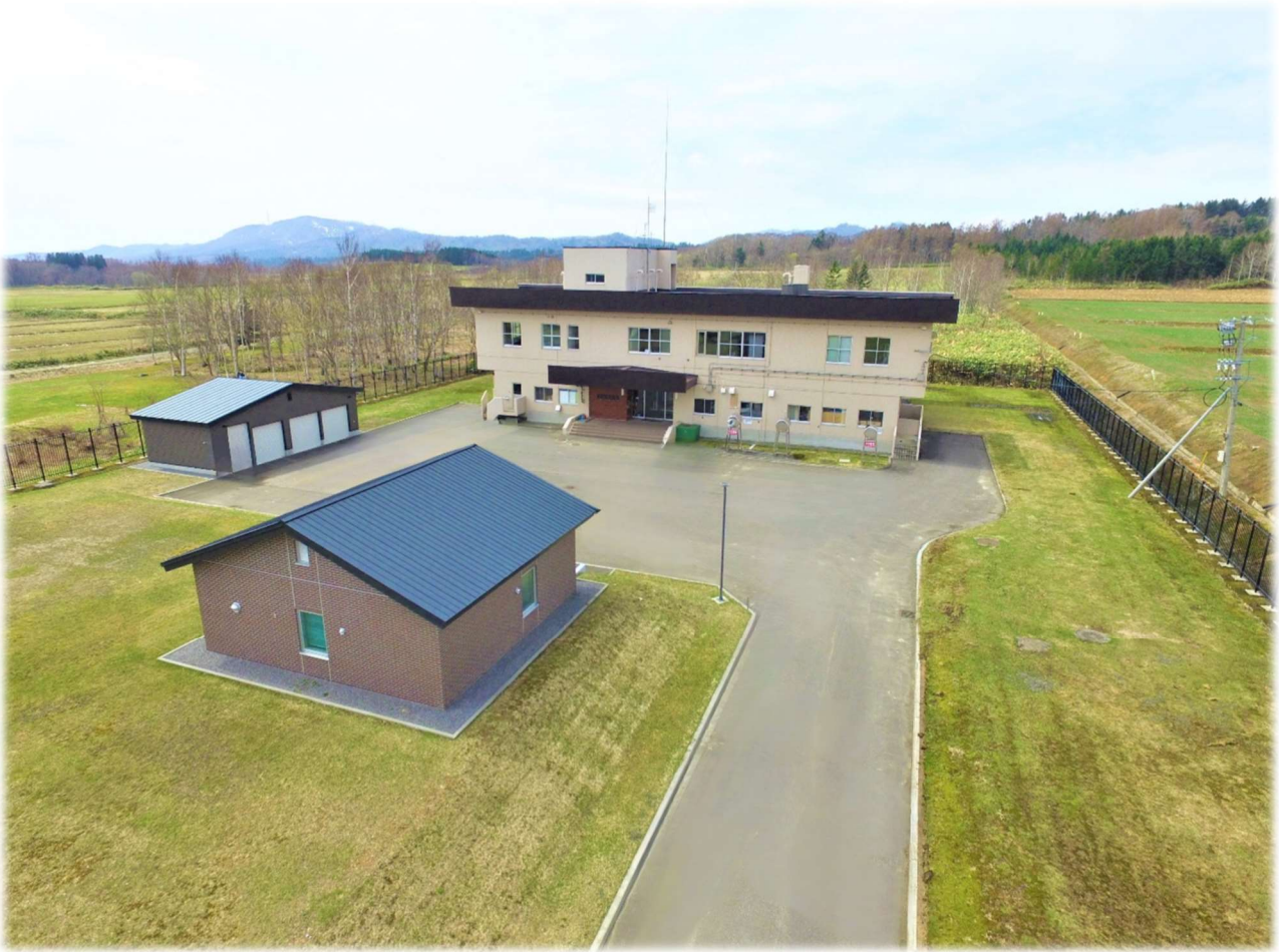
写真：月新浄水場
