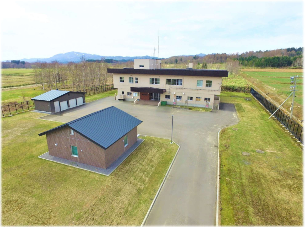
写真：月新浄水場
