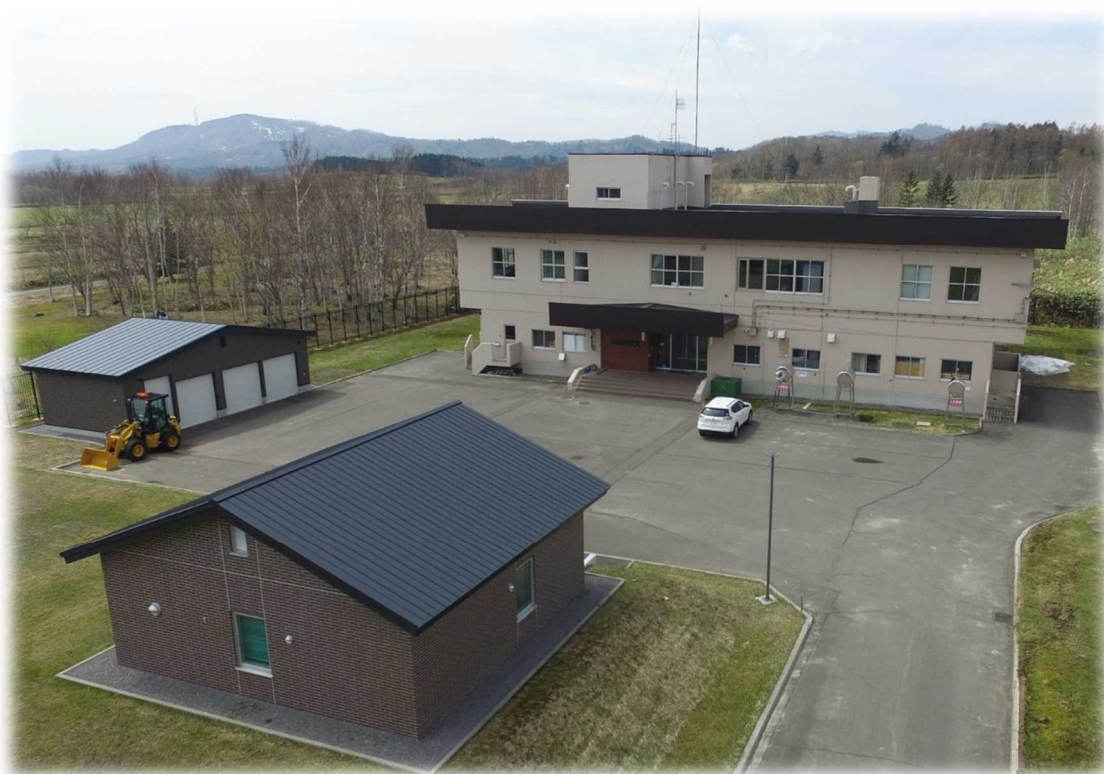
写真：月新浄水場
