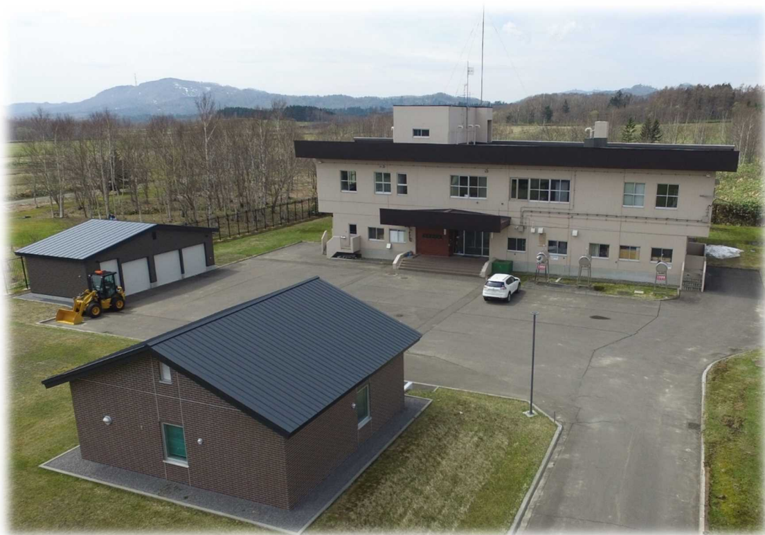
写真：月新浄水場
