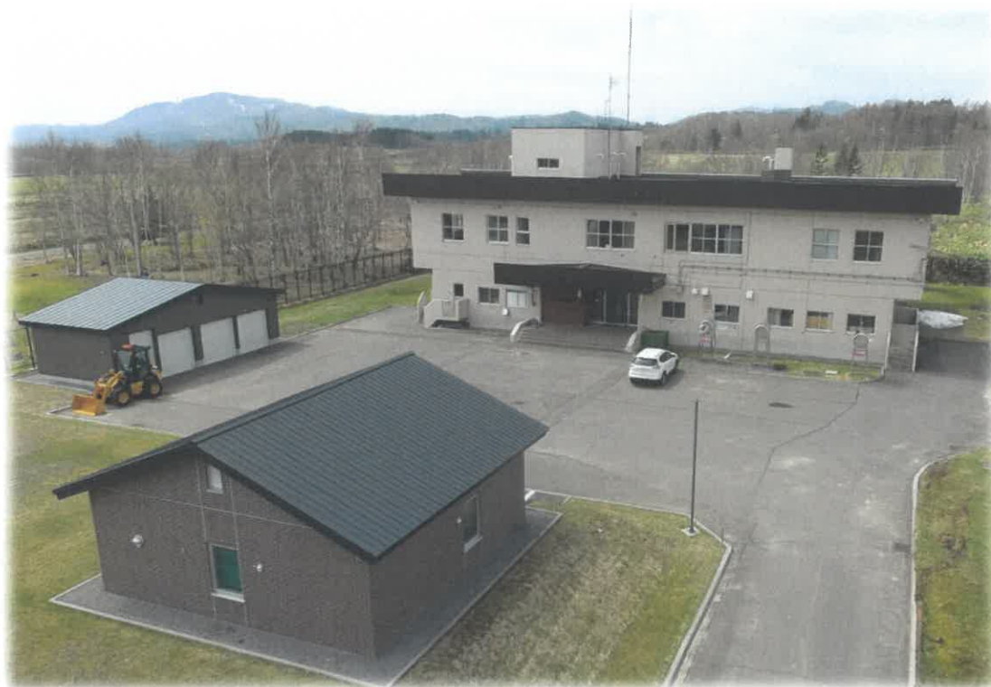
写真：月新浄水場
