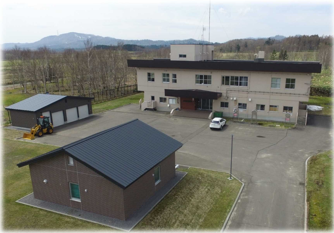
写真：月新浄水場
