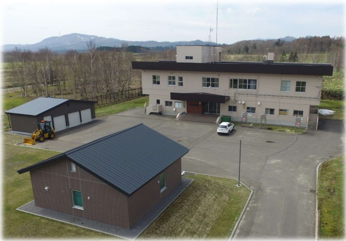
写真：月新浄水場
