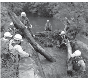
▲過酷な流木撤去作業
