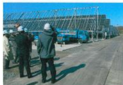
写真 11 大規模太陽光発電所建設状
