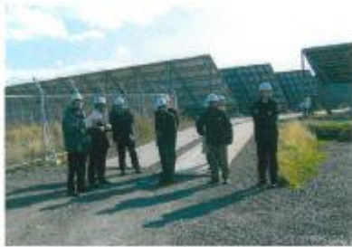
写真 8 大規模太陽光発電所
