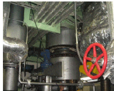
写真 2 木質系バイオマスガス化発電設備外観 写真 3 木質バイオマスガス化発電ガス化炉
